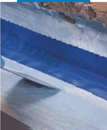
Полагане на съединение между под-стена с Mapelastic® AquaDefense
