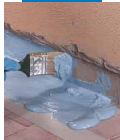
Полагане на Mapelastic® AquaDefense с четка между под и стена преди поставяне на лента Mapeband
