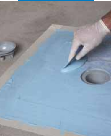
Импрегниране на вертикален отводнителен канал с Mapelastic® AquaDefense
